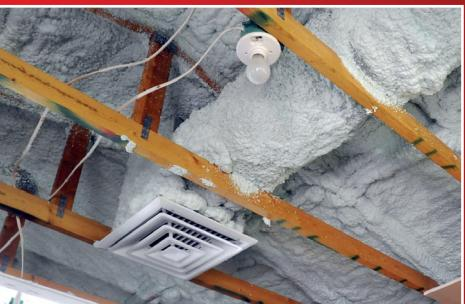
ИЗОЛЯЦИЯ ЭЛЕМЕНТОВ И КОНСТРУКЦИЙ КРЫШ И ЧЕРДАКОВ
